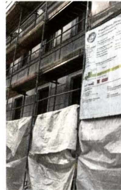
Monatelang war das Gebäude verhüllt. FOTOS: KIRF
